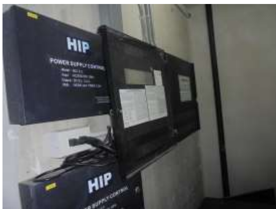
รูปที่ 29 ติดตั้งแผงควบคุมส่งสัญญาณแจ้งเหตุต่างๆ
